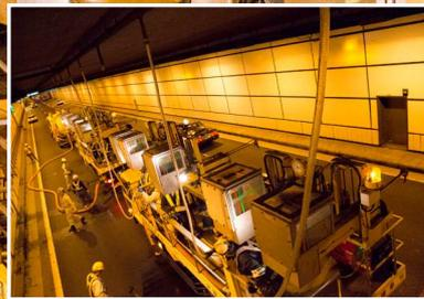
水噴霧点検車によって放水試験を行う場合、水噴霧ヘッドのピッチ間隔やトンネル内のさまざまな障害物によって、水噴霧バケットを使用できない区画が存在しています。この問題を解決するために開発したのが、カムロック方式ならびに町野式金具方式です。新しい手法と技術で、水噴霧ヘッドの位置や設置状況にかかわらず、安全かつ効率的に放水試験作業を行うことができます。
